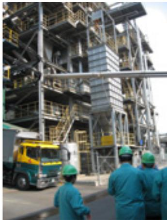
同じく呉市の中国木材株式会社バイオマス発電施設も見学させていただきました。製材過程で出る木の皮、オガクズなどをボイラーで焼却、発電に利用しています。以前は産廃として処分していたものを再利用することにしたのですが、工場の消費電力をまかなうだけでは、夜は中国電力に売電して、利益もあげていきます。
