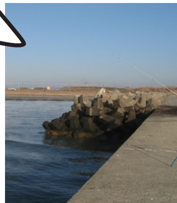
西港奥に広がる旧火力発電所建設用地
