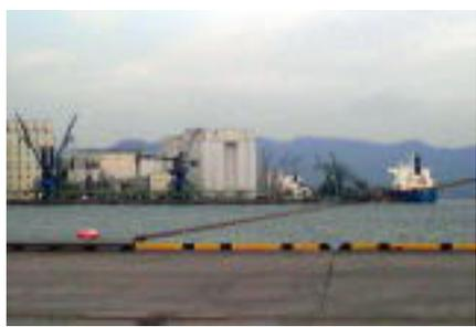
志布志港は年間の貨物取扱量が九七〇万トン、主な輸入はトウモロコシ、輸出は自動車タイヤです。国際バルク戦略港湾の整備に先立って、新若松地区に国際コンテナターミナルを整備中で、一部供用開始となっています。このコンテナターミナルに十四メートル岸壁が整備されており、この岸壁のためにつくった航路などを利用して、国際バルク戦略港湾を新たに整備しようと計画しています。
