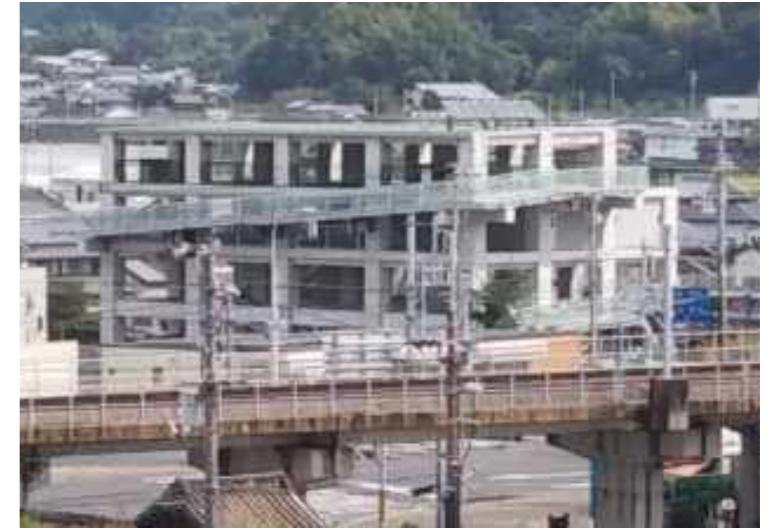
高知県香南市で設置されている津波避難タワー
