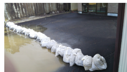
玄関前にはいち早く土嚢が積まれていました
