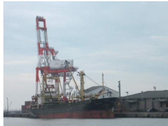
ガントリークレーン
